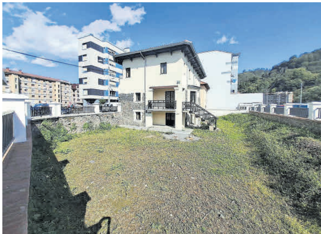
La casa del notario Vigil, vista desde un frontal.
